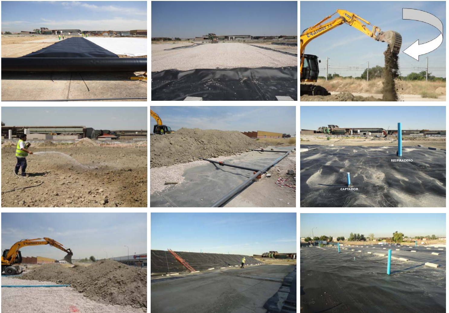
Fotografías correspondientes a la descontaminación de 22.000 m 3 de suelos con aceites hidráulicos y fuel oil, en una antigua parcela industrial en Madrid.
